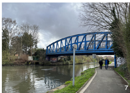
6 vue sur les GMP rénovés depuis l'arrêt n°5
